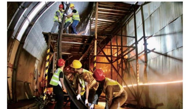
建设集团工作人员正在进行宜巴高速峡口隧道涌水应急抢险任务
