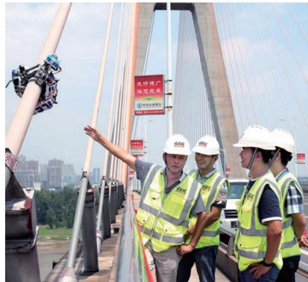
智能检测公司员工操作爬索机器人对鄂黄长江公路大桥斜拉索进行检测
